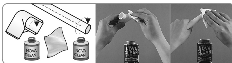
Рис. 26. Протирание очистителем Nova Clean соединяемых поверхностей
